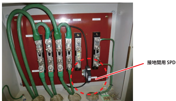
図 4-13 接地間用 SPD の設置例
