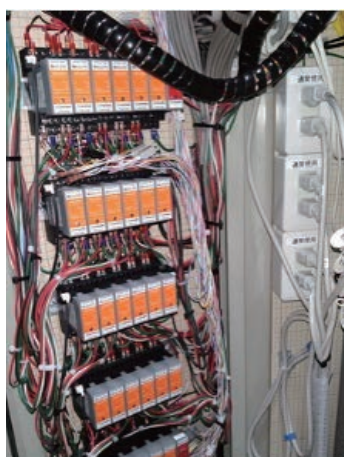
図 4-10 通信・信号設備保護のための SPD の設置例
