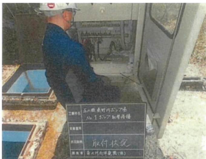
取付状況 盤内結線作業
